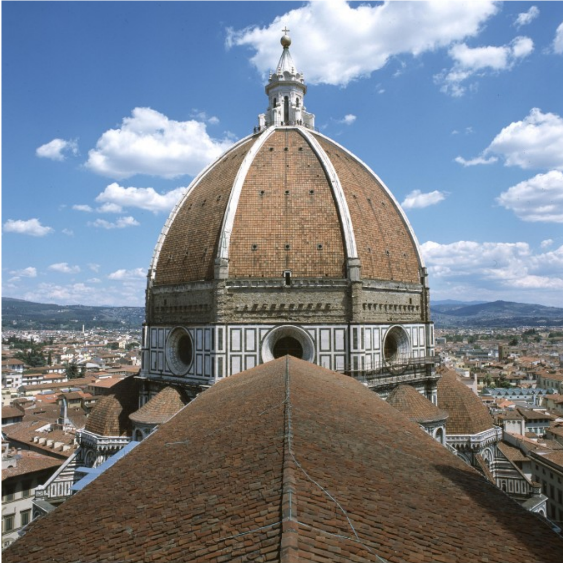
Fig. 1. La cupola di Santa Maria del Fiore vista sopra il tetto della navata della chiesa. Foto ECHO.
