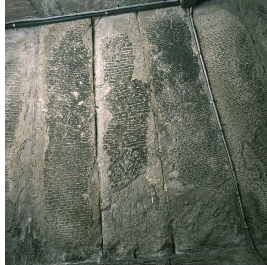
Fig. 8. Cupola di Santa Maria del Fiore, anello di chiusura, soffitto della vela 4 (sud-est) con le grandi pietre di macigno disposte a ventaglio. Foto ECHO.
