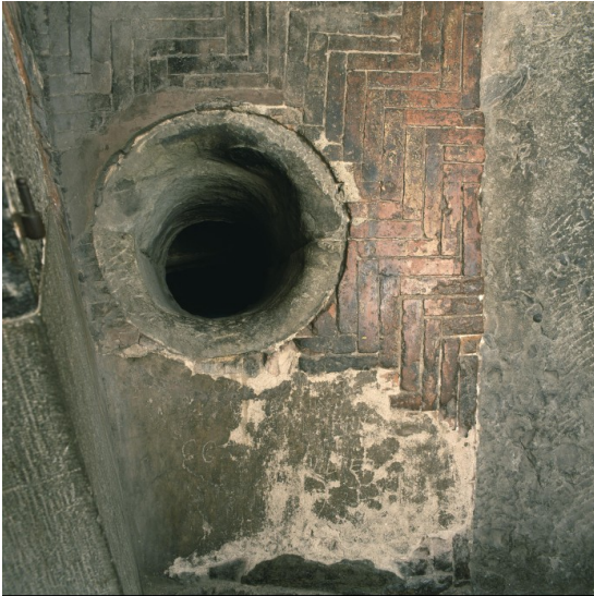
Fig. 7. Cupola di Santa Maria del Fiore, anello di chiusura, vela 1 (ovest), occhio di macigno che si affaccia al vano tra le due calotte. Foto ECHO.
