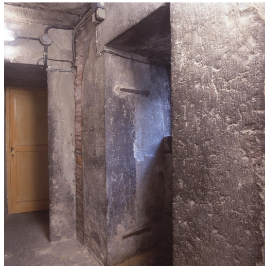
Fig. 6. Cupola di Santa Maria del Fiore, veduta dell'interno dell'anello di chiusura, vela 4 (sud-est) verso apertura nel vano della lanterna. Foto ECHO.
